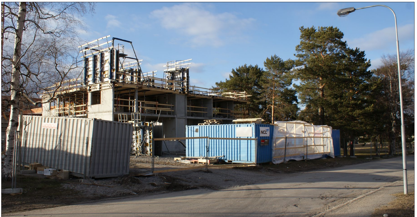
Pågående bygge av hyreslägenheter i Skönsmons centrum.
