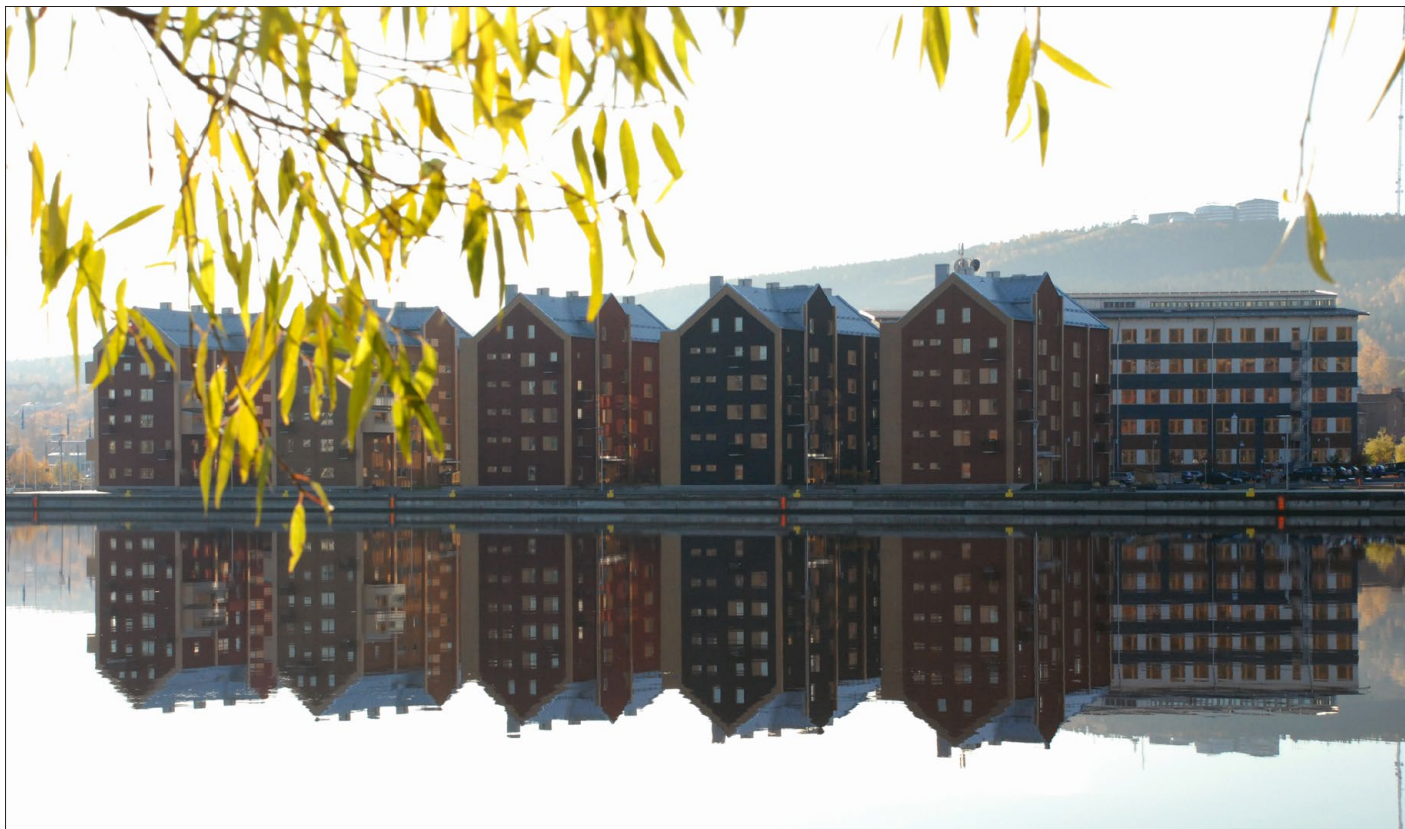
Sundsvalls kajer som är centralt belägna byggs steg för steg ut med nya bostäder.
